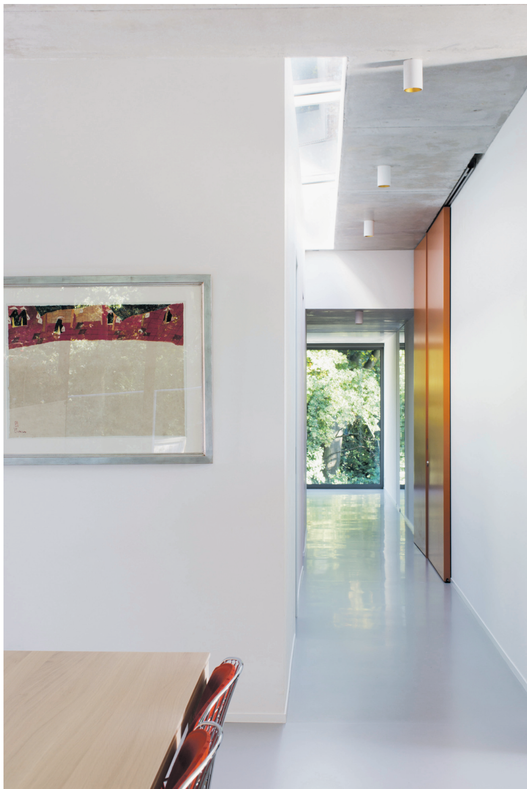
Door het verschil in hoogte tussen de dakplaten ontstonden er lichtstraten boven de centrale assen.
